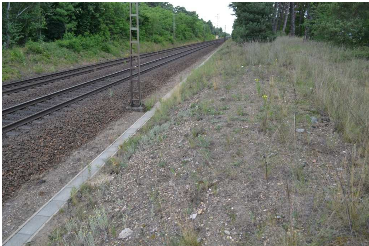
Foto 30: Bahnstrecke mit Böschung
