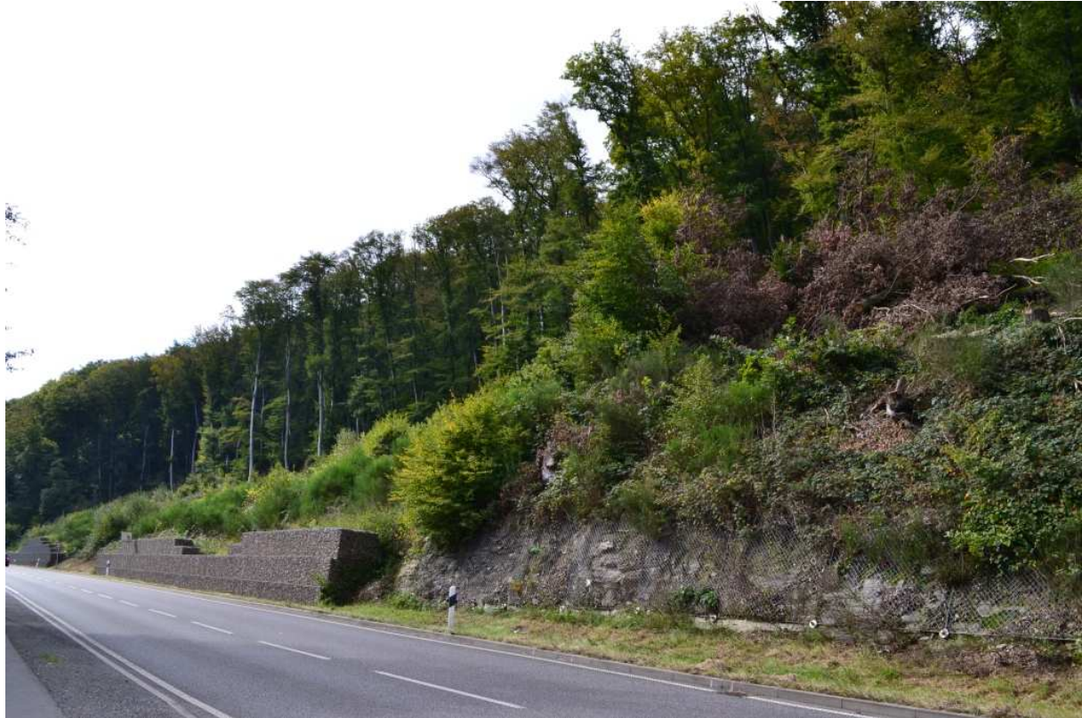
Foto 29: Gabionenwand mit angrenzendem Felsbereich
