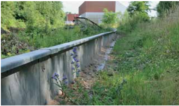
Fig. 2: A steel fence was placed between the old railway track and the newly created habitat, to prevent recolonization during the revitalization work. Note the projection of fusion edges. / Abb. 2: Stahlzaun zwischen alter Bahnstrecke und dem neu gestalteten Habitat zur Verhinderung der Rückwanderung während der Rekonstruktionsarbeiten. Photo/Foto: D. FRISSEN.
