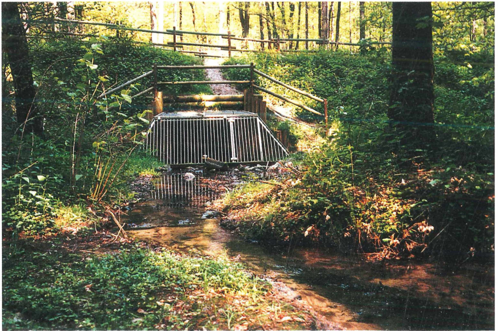
Abb. 13: Der Bau von Regenrückhaltebecken und Hochwasserretentionsmaßnahmen, wie hier im Aplerbecker Wald, verändern die Vorflut und gefährden vor allem die Feuersalamanderlarven.
