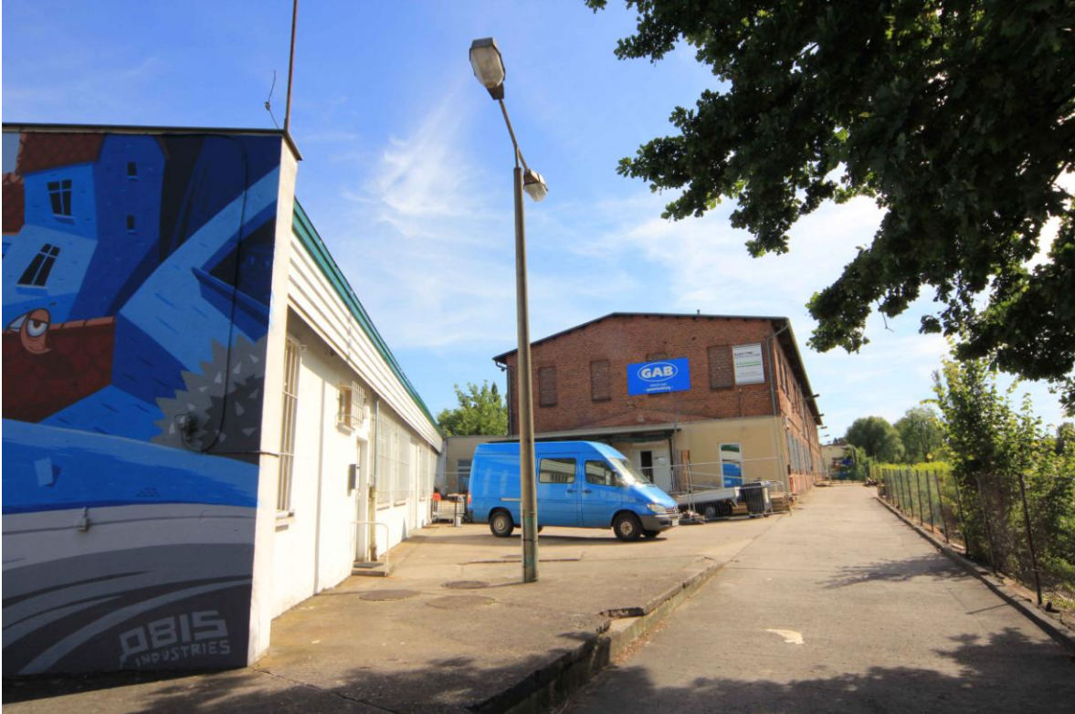
Abb. 5: Blick vom Nordosten entlang der Gebäude
