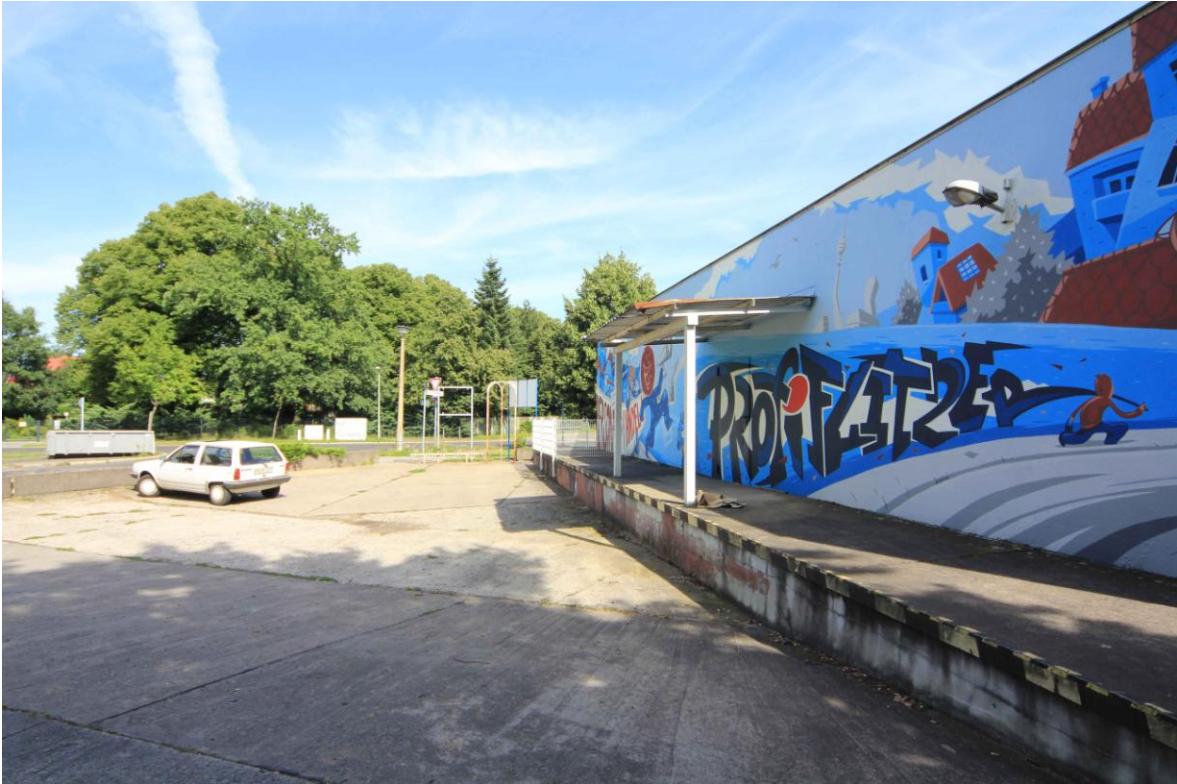
Abb. 2: Parkfläche an der Idunastraße im Nordosten
