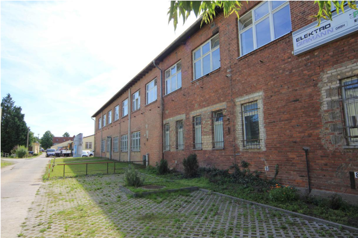
Abb. 3: Gewerblich genutzte Gebäude im Osten des B-Plangebietes
