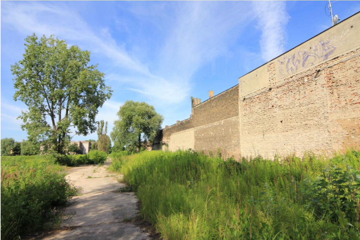
Abb. 6: Brandmauern bzw. Rückseite der Gebäude
