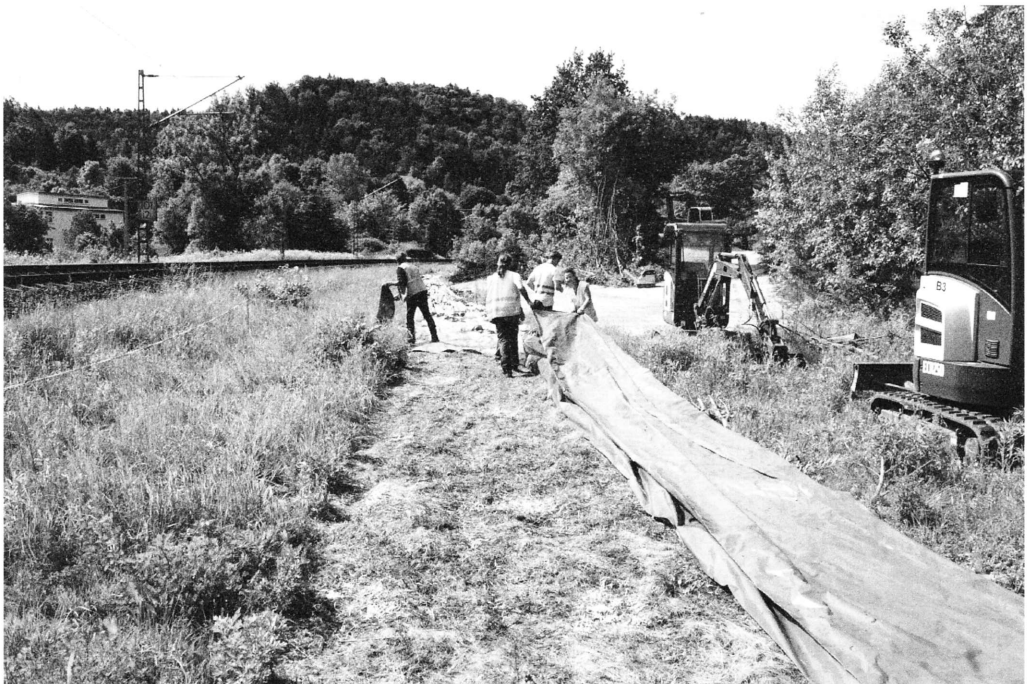
Abb. 1: Entfernung der Vergrämungsfolie zur Baufeldfreimachung entlang der Gäubahn. Removal of plastic sheet for site preparation along the Gäubahn.
